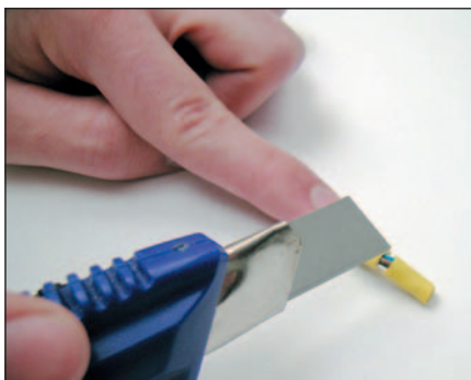
Острым ножом снимите с кабеля кусочек изоляции
